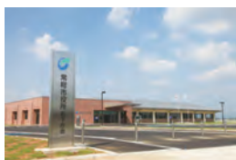
石下庁舎 会議室2 (新石下 4310-1)
