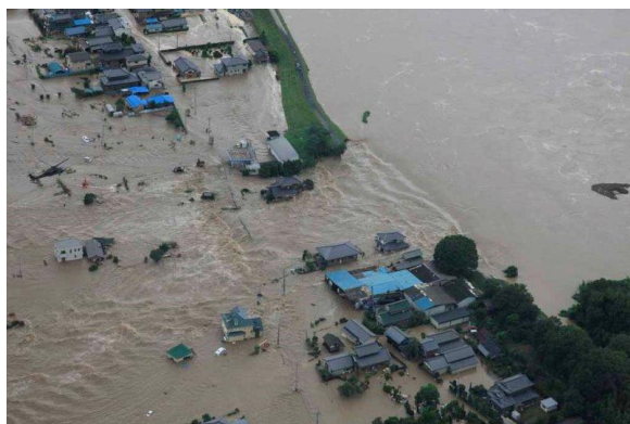
決壊した堤防
