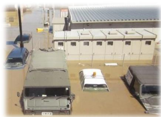
非常用発電機
