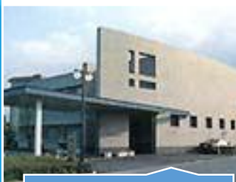
常総市 生涯学習センター
