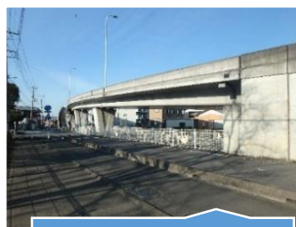
水海道跨線橋
