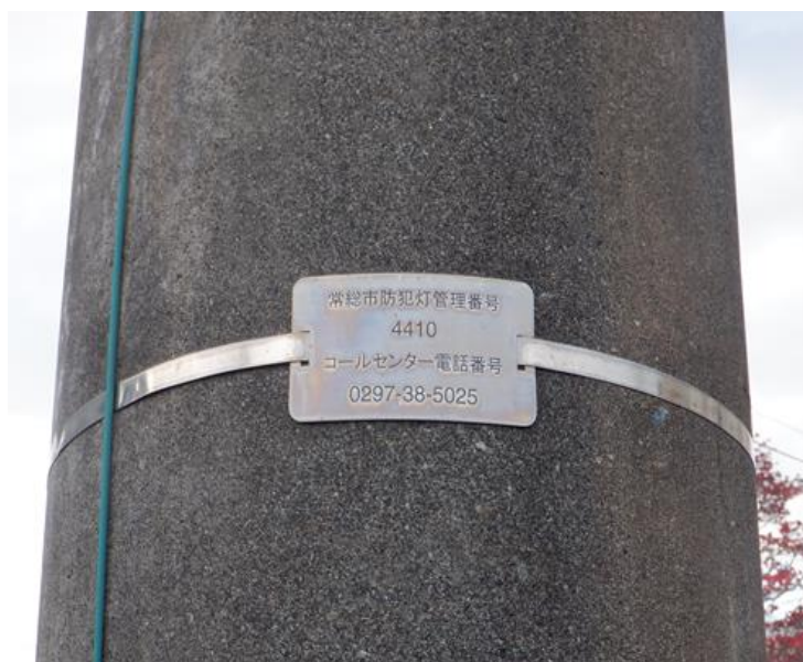
常総市防犯灯 管理プレートの写真
