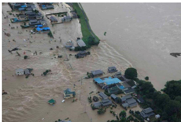
決壊した堤防
