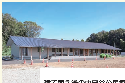
建て替え後の内守谷公民館
