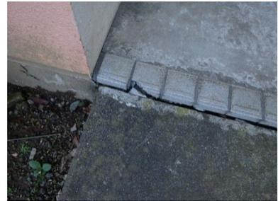
住棟入口 タイル破損、地盤沈下
