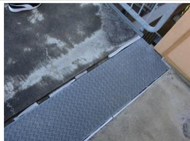
外階段との接続部 目地の破損
