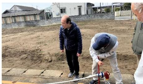
消火栓にホースを接続し、バルブを専用開栓具で開栓！
