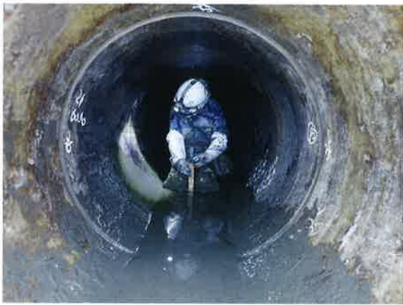
八千代幹線(上流側)の調査状況
