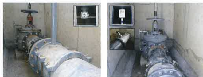
整備前(5号分水工φ400) 整備後(5号分水工φ400)
