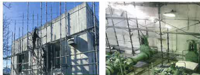
外壁補修工の様子 内部防音工の様子
