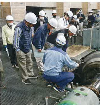
ポンプ内部の劣化状況確認
