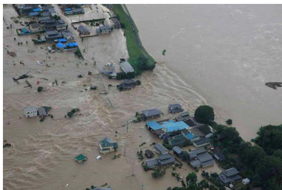
決壊した堤防
