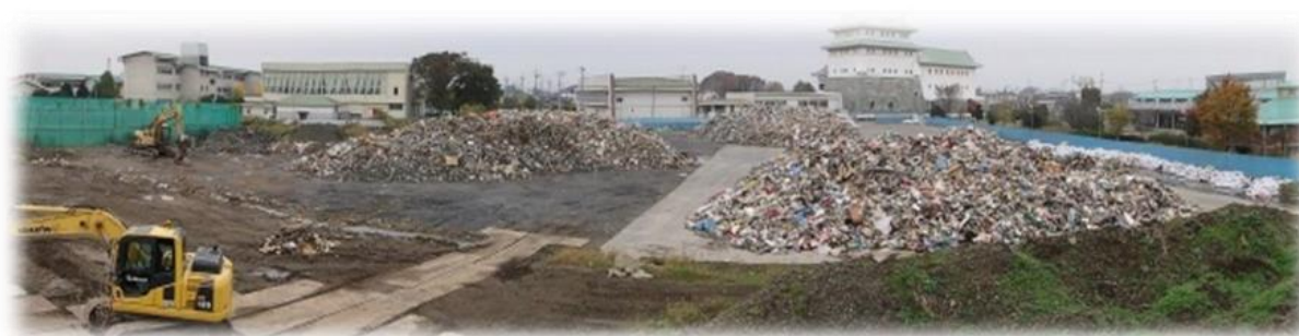
地域交流センター東側駐車場の仮置場
