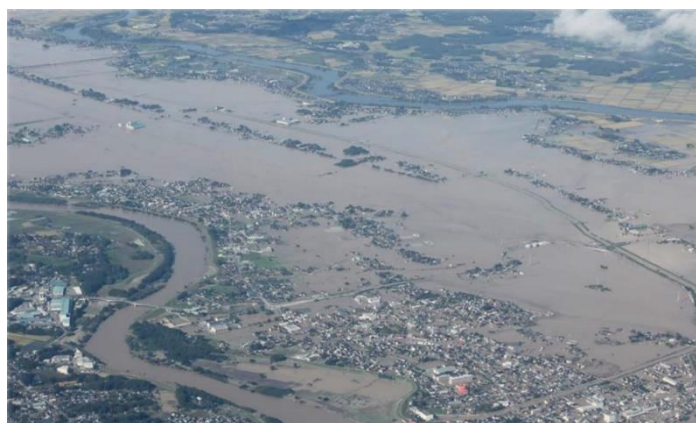
常総市の浸水状況（2015（平成 27）年 9 月 10 日国土交通省撮影）
