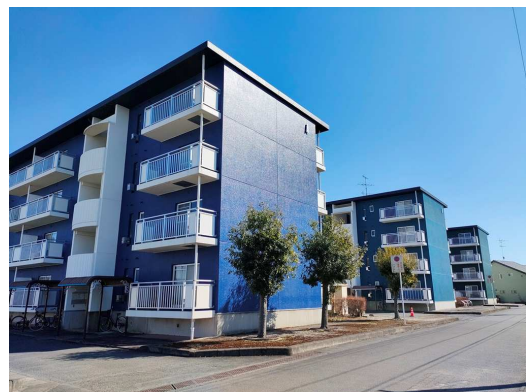
改修工事終了後の市営住宅
