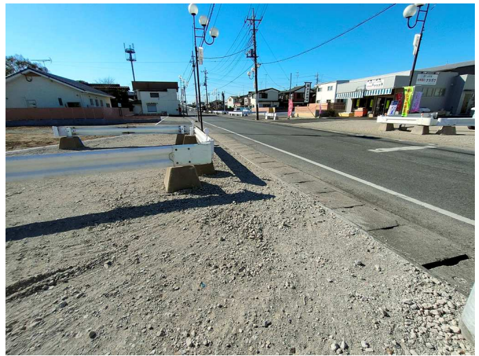
石下駅周辺整備の様子
