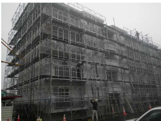
市営住宅の改修の様子
