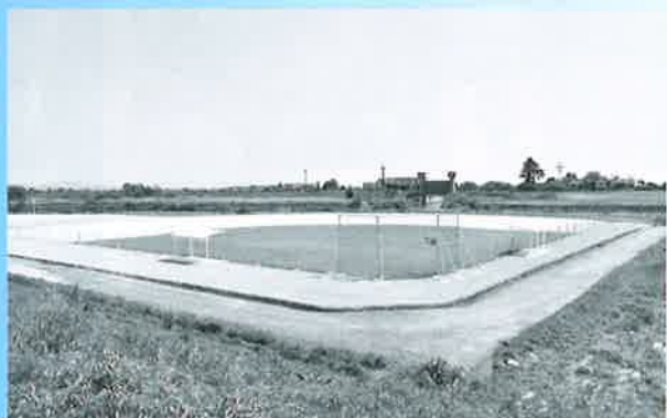
完成した豊岡球場の全景
