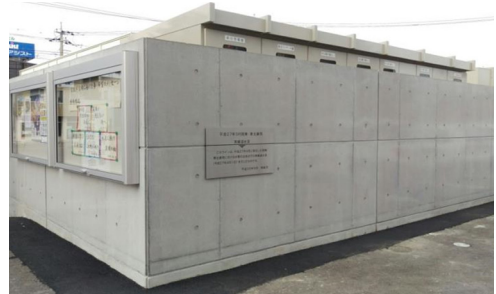
非常用電源を守るために防水壁を設置した状況
