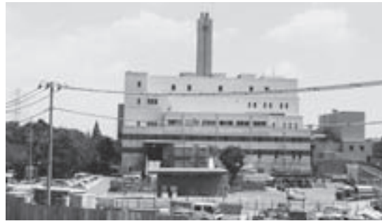
常総環境センター
