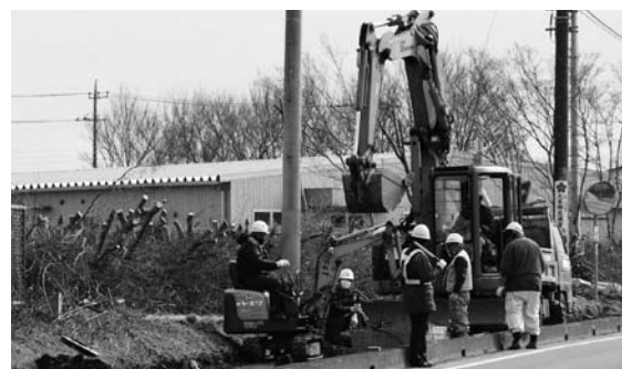
道路工事現場
