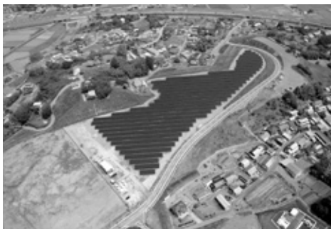
太田太陽光発電所
