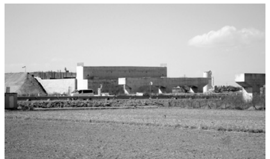
工事中の(仮称)水海道インターチェンジ
