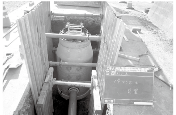
整備の進む公共下水道
