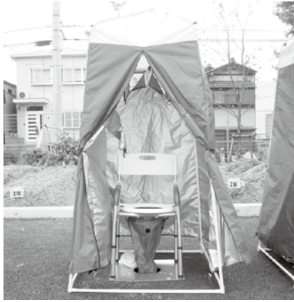
マンホールトイレの一例
