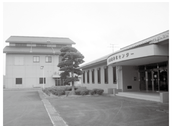
水海道浄化センター
