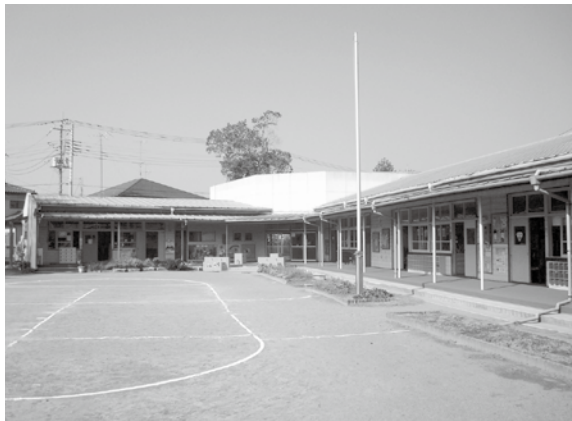
老朽化した園舎（玉幼稚園）
