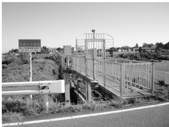
坂巻排水樋管
