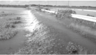
飯沼川排水路溢水現場
