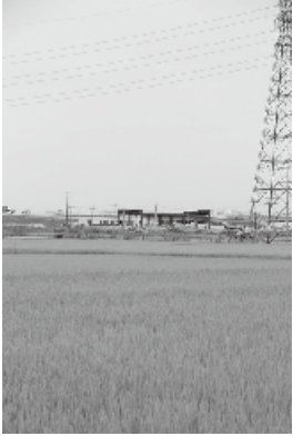
圏央道 常総インターチェンジ周辺
