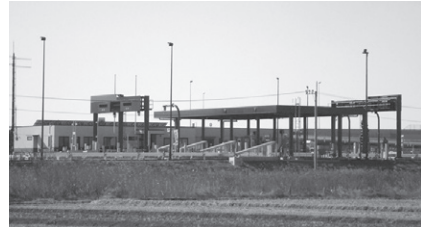
圏央道常総インターチェンジ
