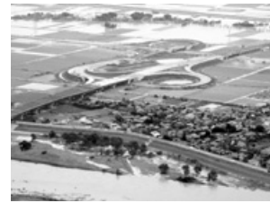
圏央道常総インターチェンジ付近
