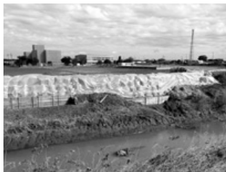
八間堀川決壊現場付近
