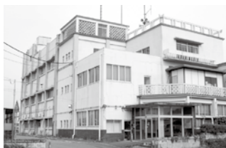
解体予定の旧石下庁舎
