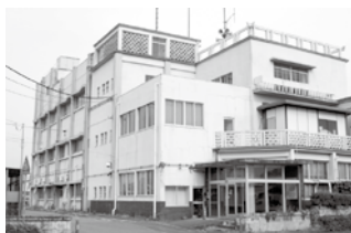
解体予定の旧石下庁舎
