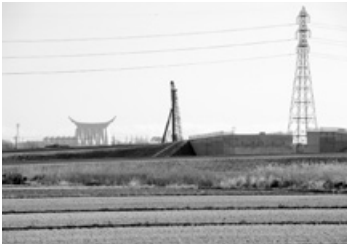
圏央道常総インターチェンジ周辺
