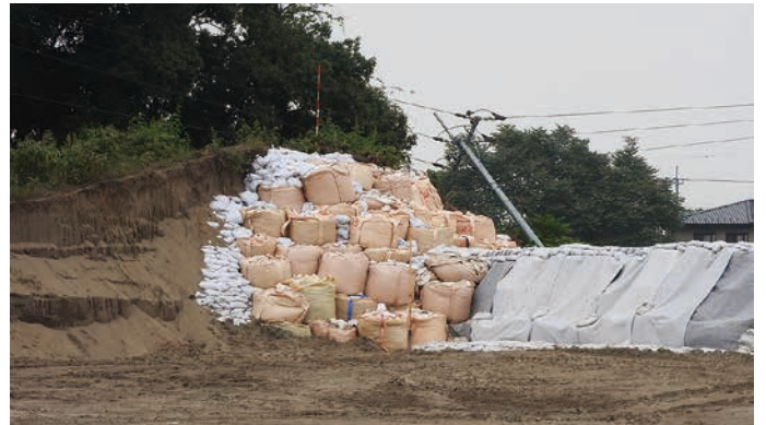
土のうが積まれ、9月25日には溢水現場の応急対策が終了した（9月24日、若宮戸）
