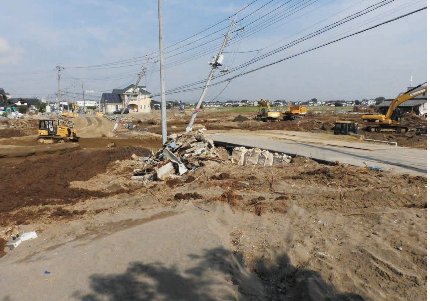
急ピッチで復旧工事が進められる県道谷和原筑西線（10月20日、三坂町）
