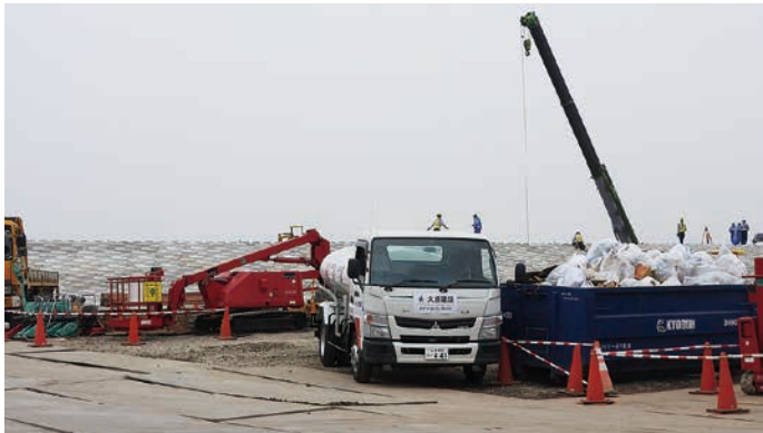
決壊した堤防の応急復旧工事が完了し、避難勧告、避難指示が9月25日に解除された（9月24日、三坂町）
