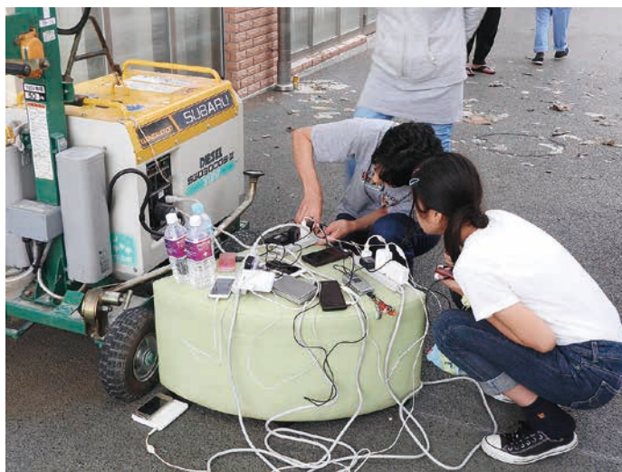
停電のため、市役所に設置された発電機で携帯電話の充電をする市民（9月12日、水海道諏訪町）
