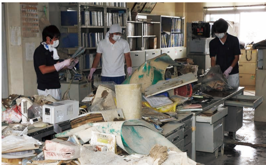
浸水により散乱した相野谷浄水場の事務室内（9月24日、相野谷町）
