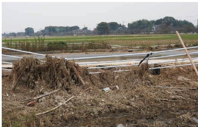
濁流の勢いでごみが流され押し倒された道路柵（9月24日、沖新田町）
