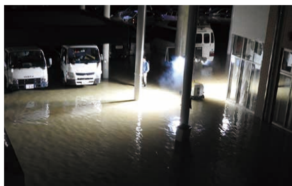
市役所本庁舎にも浸水が始まる （9月11日午前2時19分、水海道諏訪町）
