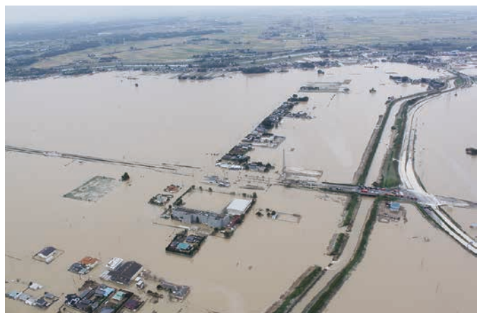
八間堀川の2か所が決壊した大生小学校付近上空（9月13日午後2時9分、平町）
