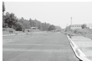
西幹線道路（鹿小路細野線） 坂手工業団地北側付近
