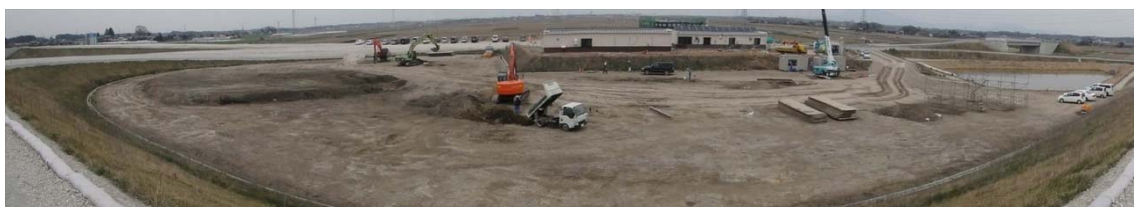
災害廃棄物搬出後（平成 28 年 3 月 30 日撮影）
