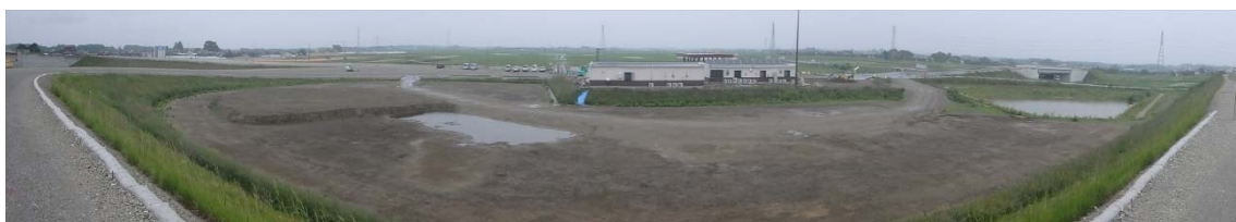
原状復旧完了後（平成 28 年 5 月 30 日撮影）
