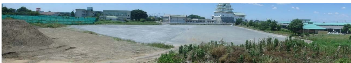
原状復旧完了後（平成28年6月2日撮影）
