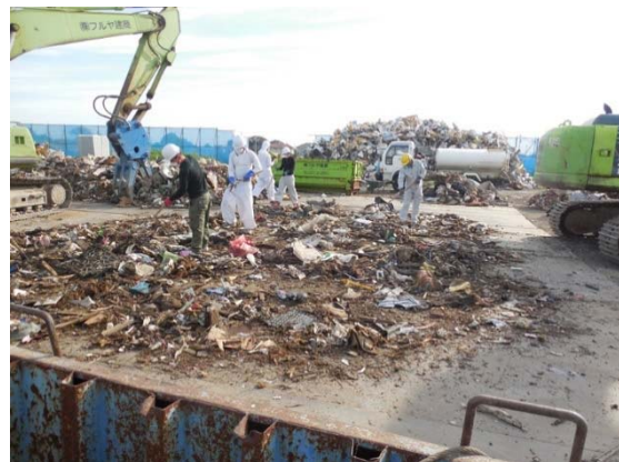
バックホウと人力による 災害廃棄物の分別
