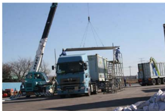
海上コンテナの蓋閉め作業 (地域交流センター東側駐車場)
