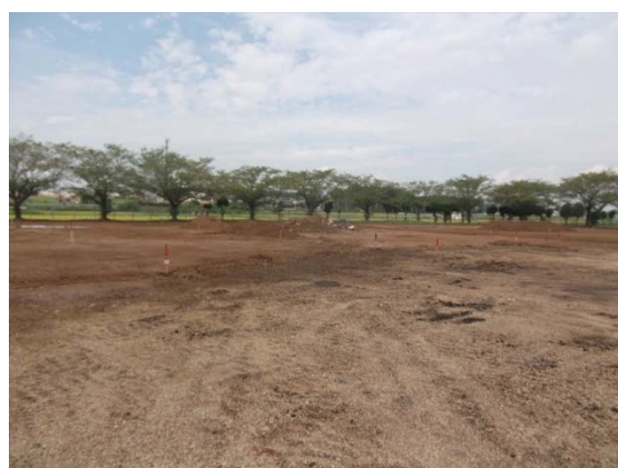
入れ替え工事完了後の地面 (宝堀球場)
