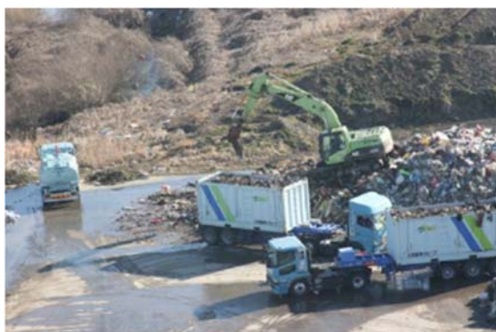
海上コンテナへの積込 (地域交流センター東側駐車場)
