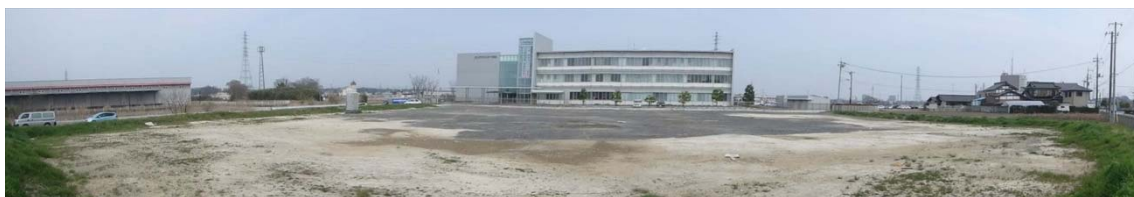
災害廃棄物搬出後（平成28年3月30日撮影）
