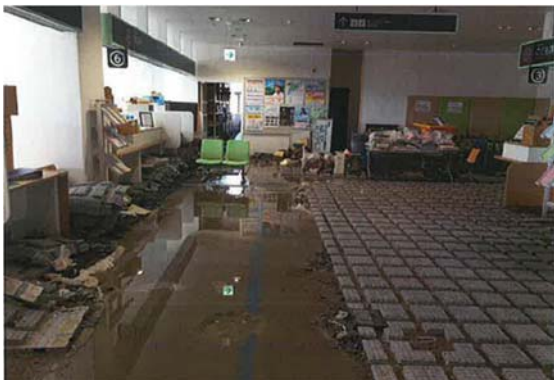
床一面に泥が残った作業前の本庁舎内
