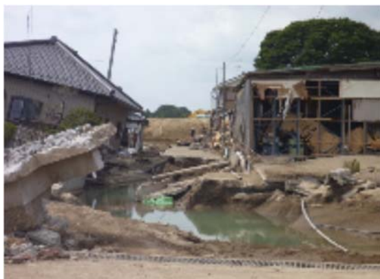
決壊現場付近 上三坂地区
