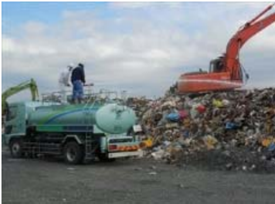
散水による粉じんの発生防止
