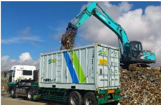
仮置場での海上コンテナへの積込
