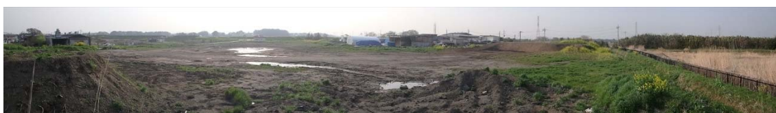
原状復旧工事完了後（平成28年4月6日撮影）
