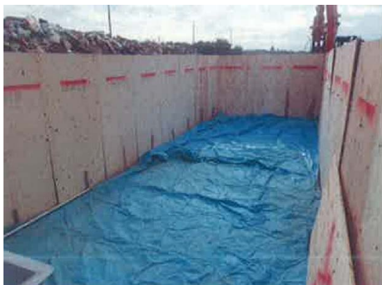
仮設枠（投入前）
