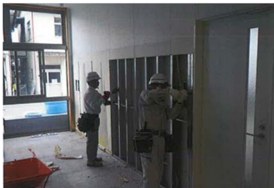
壁・ボードクロスの撤去作業
