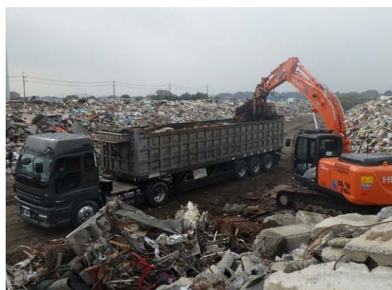
廃置の緊急搬出 (きぬアクアステーション)
