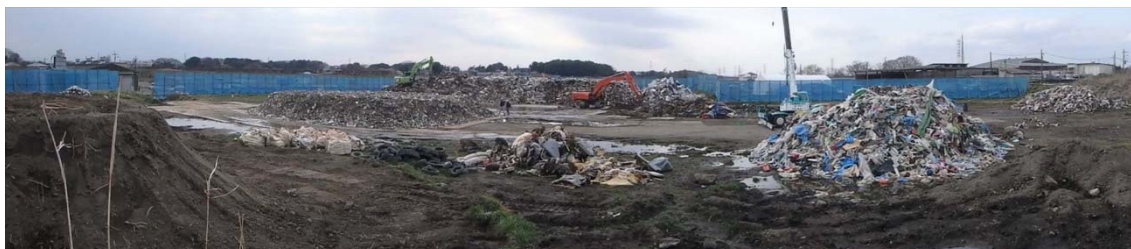
災害廃棄物搬出前（平成28年2月22日撮影）
