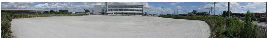
原状復旧完了後（平成28年8月1日撮影）
