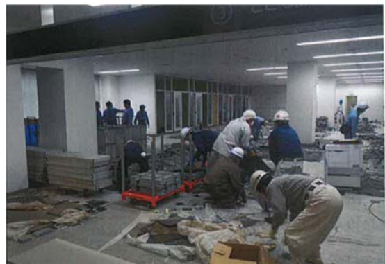
床材の撤去作業
