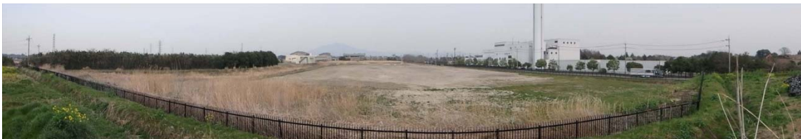
災害廃棄物搬出後（平成28年3月30日撮影）
