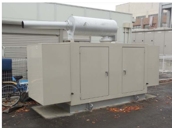
写真 1-1-6 自家発電機の設置（写真は予備機、市役所本庁舎前）
