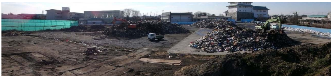
災害廃棄物搬出前（平成28年2月3日撮影）
