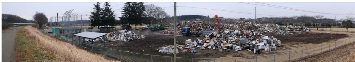
災害廃棄物搬出前（平成28年2月1日撮影）
