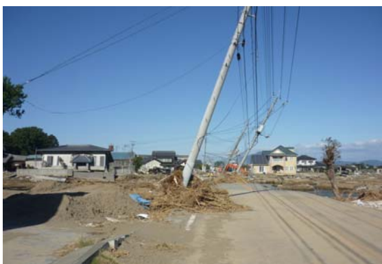
決壊現場付近
