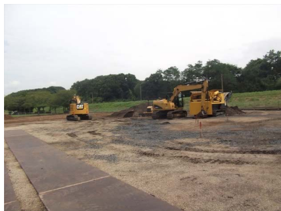
土砂の入れ替え工事 (宝堀球場)
