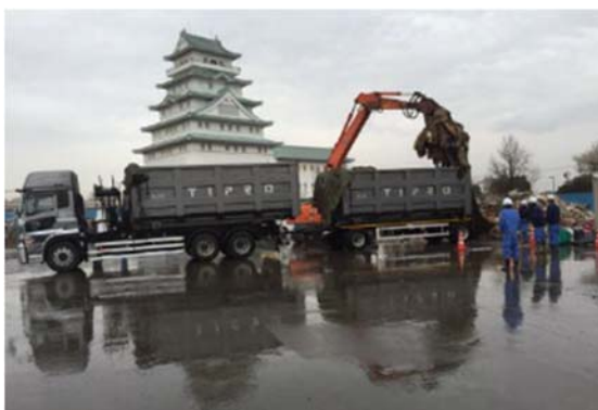
陸送用フルトレーラーへの積込 (地域交流センター東側駐車場)
