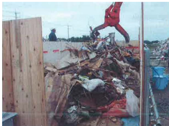
重機によるごみの投入
