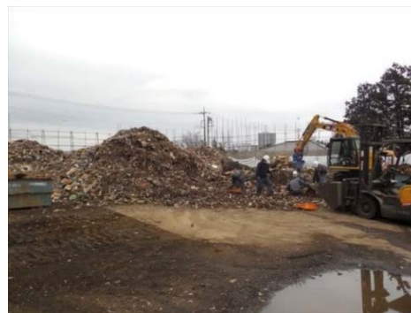
重機による災害廃棄物の選別
