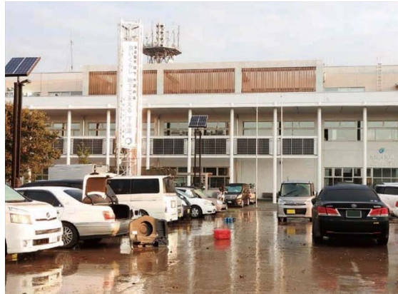
水が引いた後の市役所本庁舎前の駐車場
