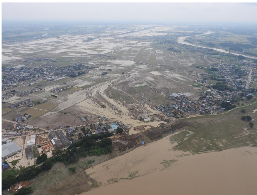
一級河川「鬼怒川（きぬがわ）」決壊現場
