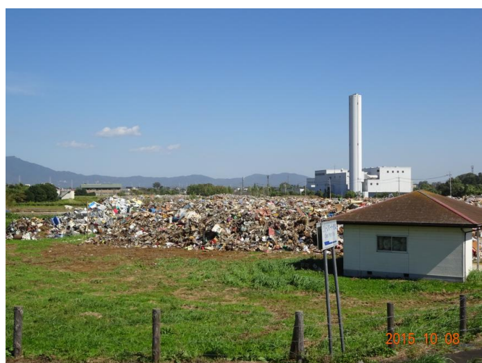
ごみ焼却処理施設「クリーンポート・きぬ」 (平成 27 年 9 月関東・東北豪雨災害時) 撮影：常総市
