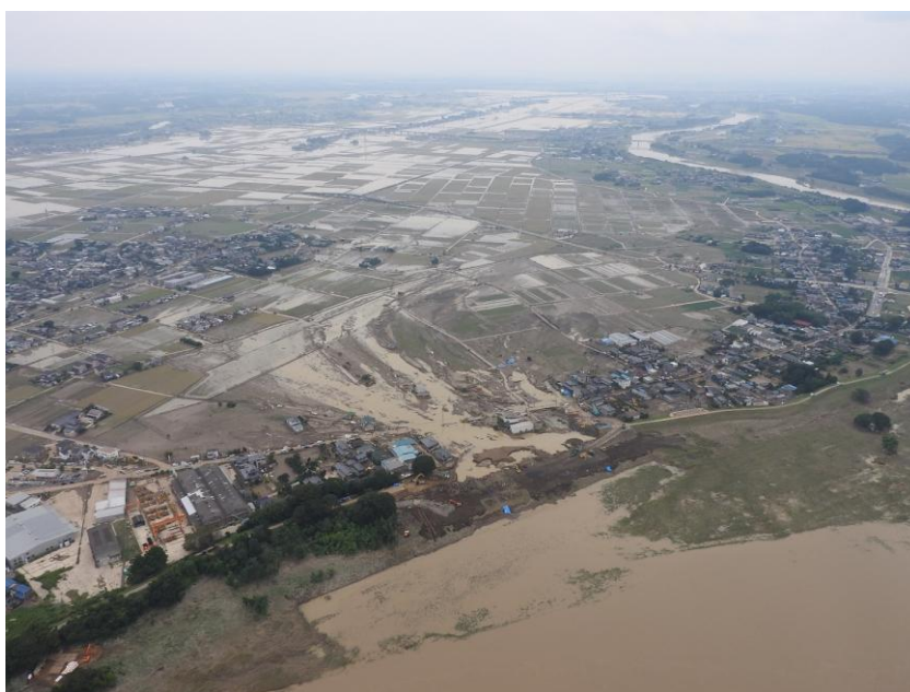
一級河川「鬼怒川（きぬがわ）」決壊現場
