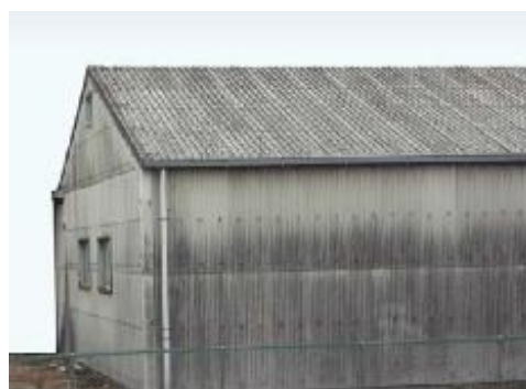
石綿含有スレート波板（屋根・外壁）
