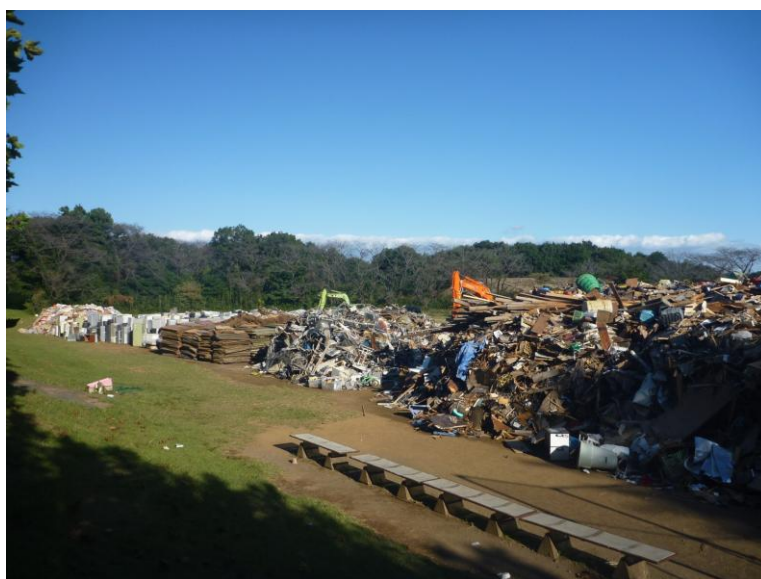
常総市青少年の家仮置場 （平成 27 年 9 月関東・東北豪雨災害） 撮影：常総市
