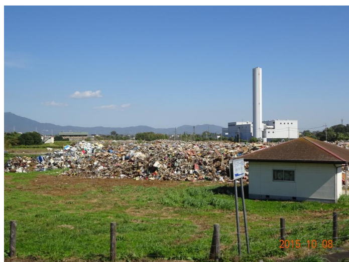
ごみ焼却処理施設「クリーンポート・きぬ」
