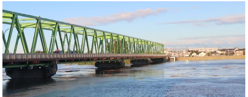
各地で被害があった令和元年の洪水も安全に流下させました。
