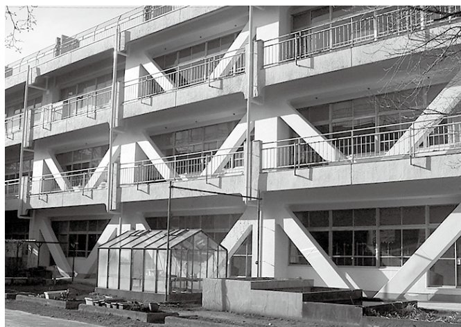
耐震補強された水海道小学校校舎
