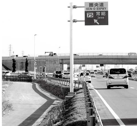
開通した圏央道常総IC
