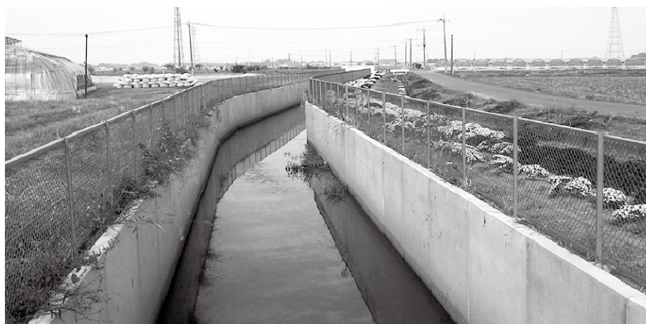
整備された江連都市下水路
