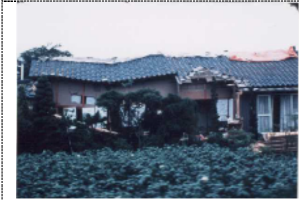
出典：被災建築物応急危険度判定マニュアル (一般財団法人 日本建築防災協会)
