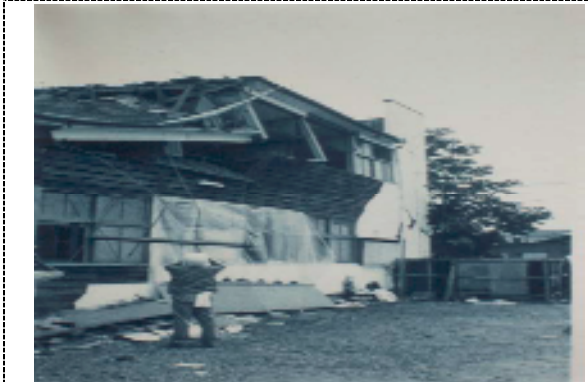
出典：被災建築物応急危険度判定マニュアル (一般財団法人 日本建築防災協会)
