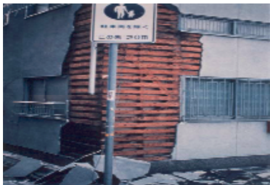
出典：被災建築物応急危険度判定マニュアル (一般財団法人 日本建築防災協会)
