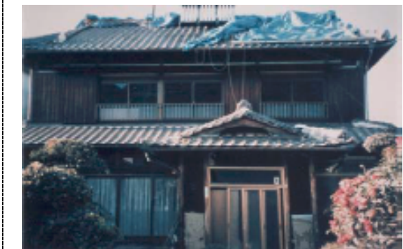
出典：被災建築物応急危険度判定マニュアル (一般財団法人 日本建築防災協会)
