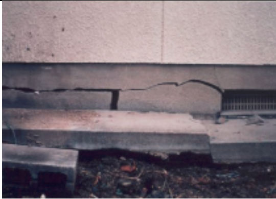
出典：被災建築物応急危険度判定マニュアル (一般財団法人 日本建築防災協会)
