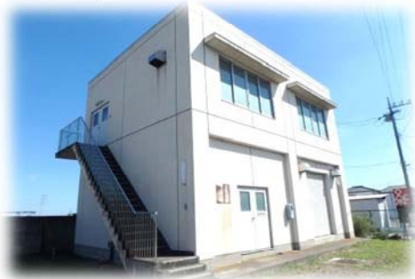
東部電気・発電機室
