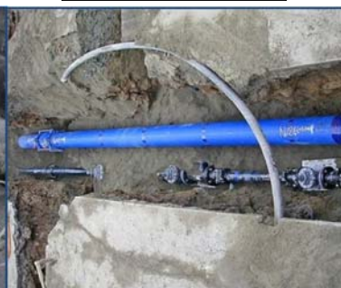
配水ポリエチレン管布設
