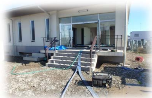
東部浄水場復旧作業
