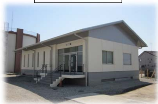
東部配水ポンプ電気室
