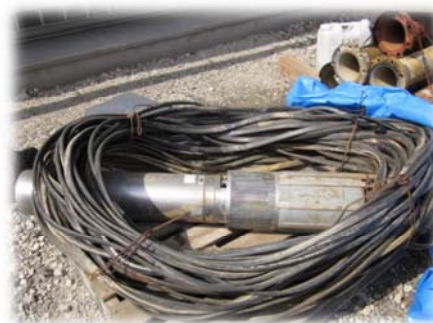
取水ポンプ撤去
