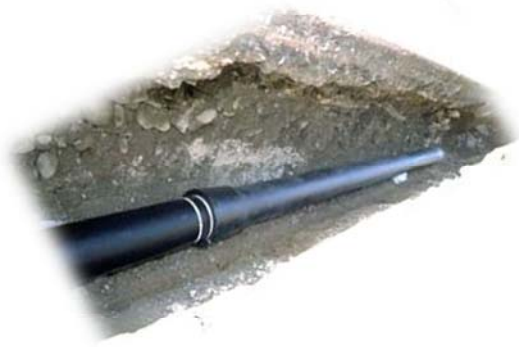
ダクタイル鋳鉄管の布設
