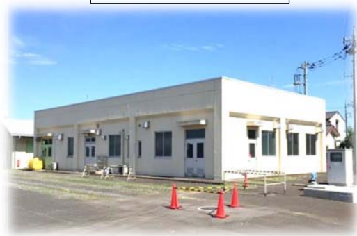
西部配水ポンプ電気室
