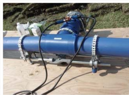
更新後配水ポリエチレン管の融着作業
