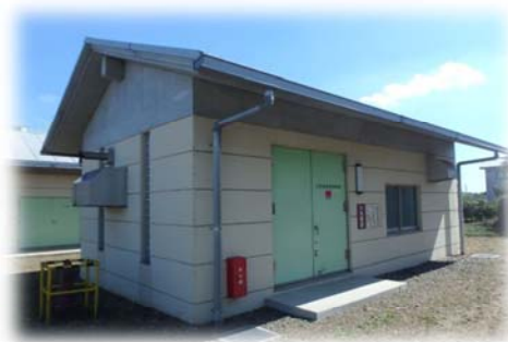
西部発電機室
