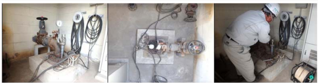
取水施設点検・調査
