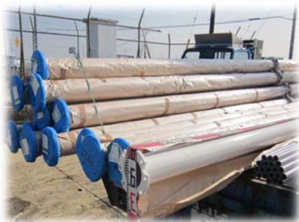
取水ポンプ更新
