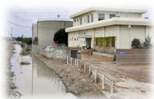
相野谷浄水場水害状況
