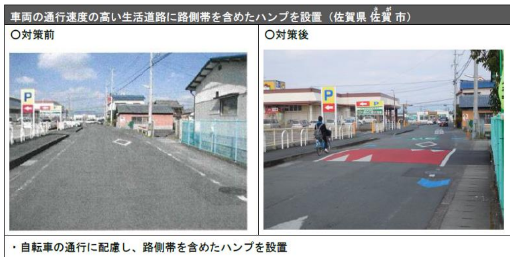
自転車の通行に配慮したハンプ設置【出典:国土交通省】
