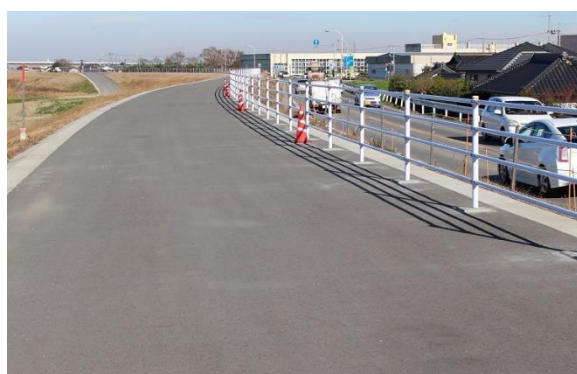
危険箇所への防護柵設置
