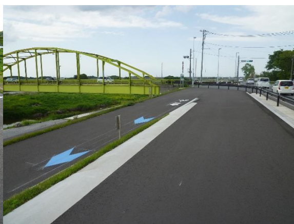
矢羽根型路面標示(堤防天端)
