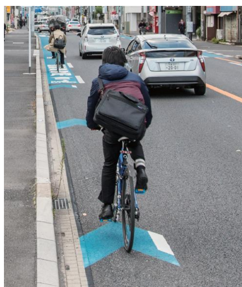
矢羽根型路面標示(車道混在)
