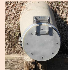
■ フラップゲート設置
