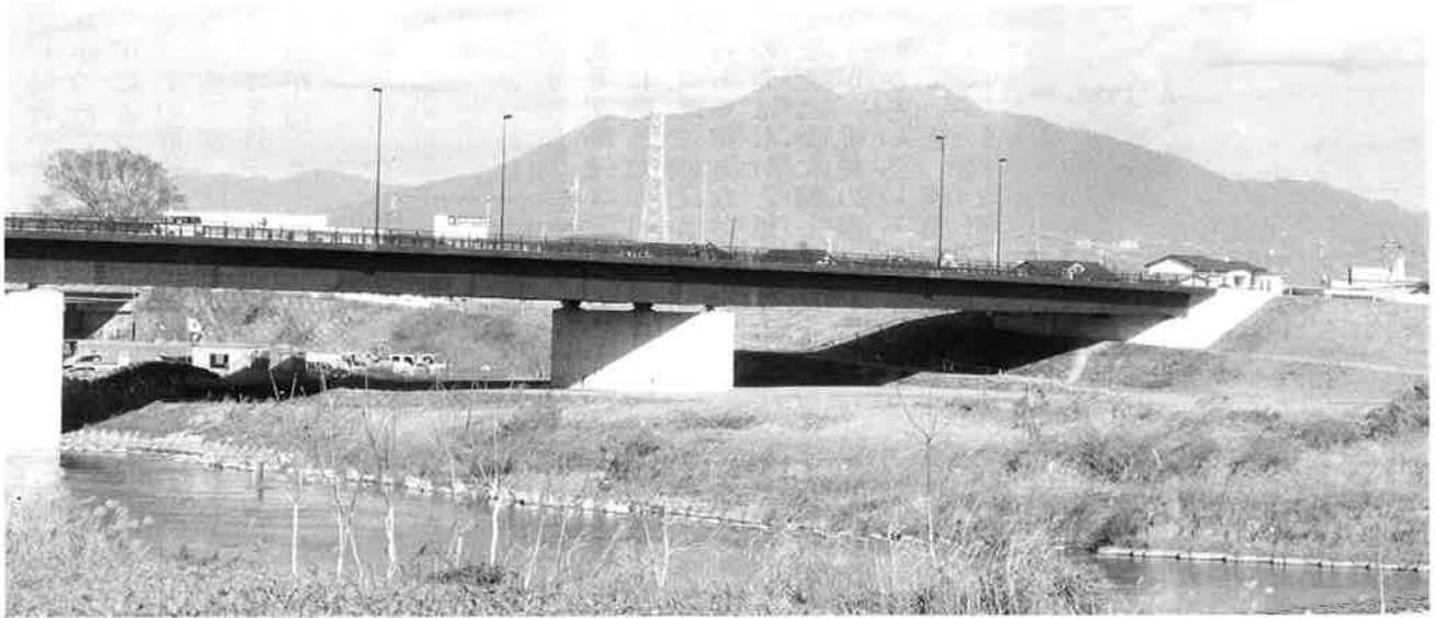
昨年末に開通した石下橋から筑波山を望む
