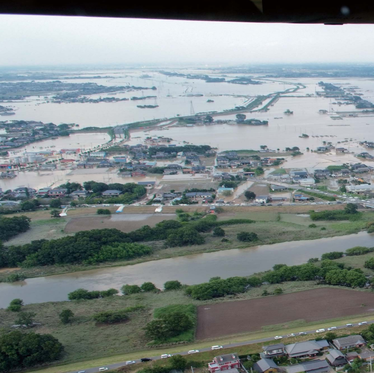
▲水害時の大和橋付近上空（陸上自衛隊航空学校霞ヶ浦校撮影）
